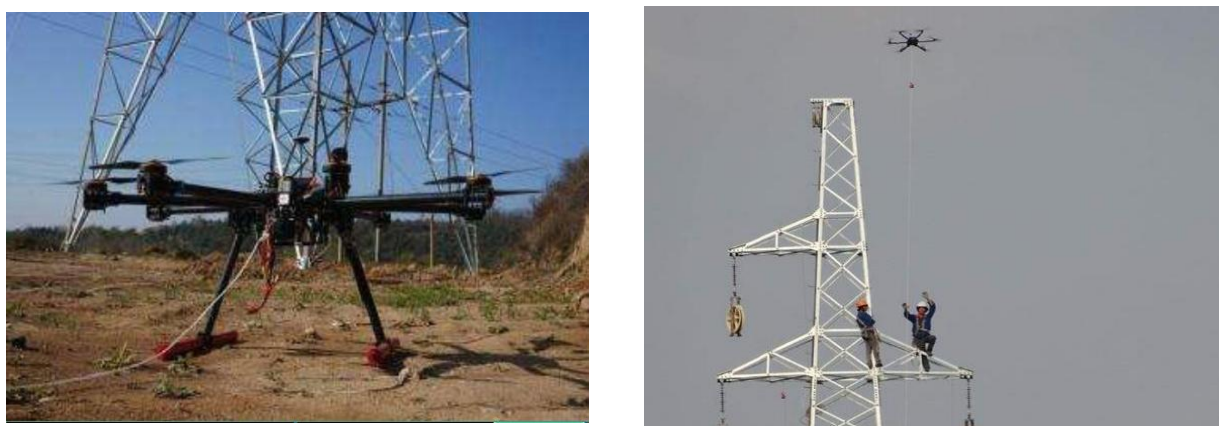
图 1-2 类似线路工程无人机展架线现场图
