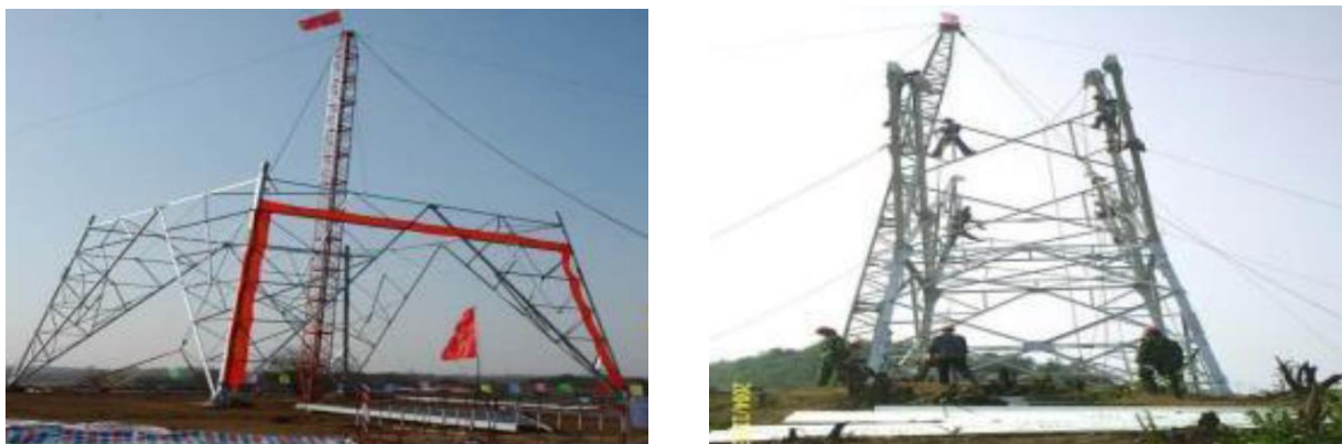
图 1-1 类似线路工程铁塔组装现场图
